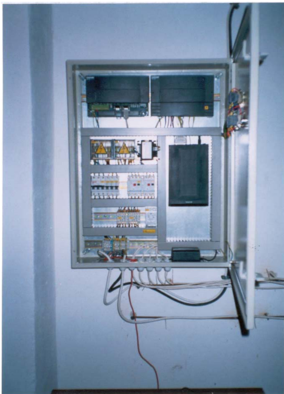
Електрическо табло с дистанционно управление и система за мониторинг на слънчевата колекторна инсталация
