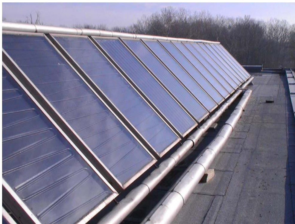
detajl SSE in cevovodi
